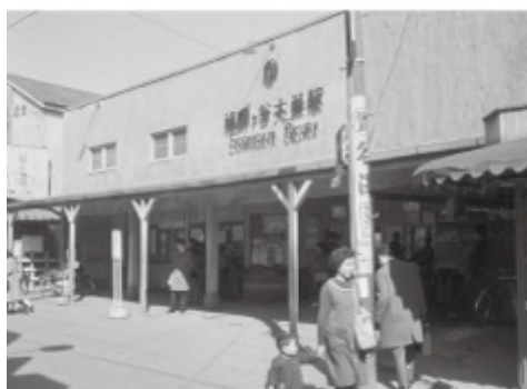
高架前の祖師ヶ谷大蔵駅
