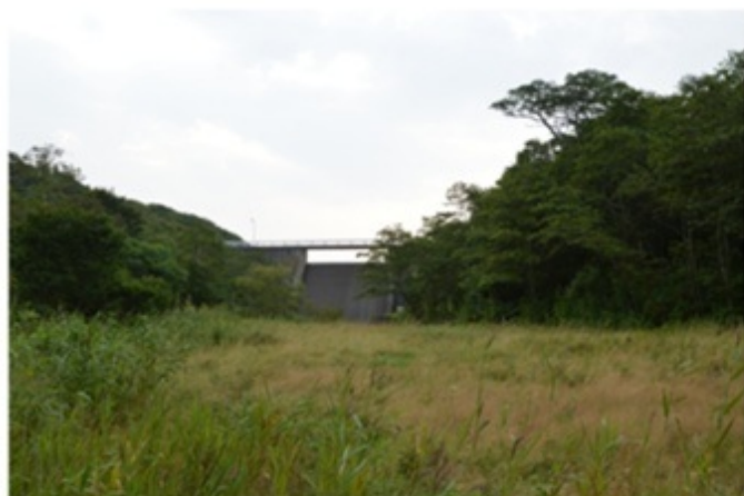
日本最東端のダム 牧の内ダム
