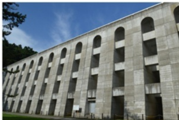
道内唯一のバットレスダムの笹流ダム
