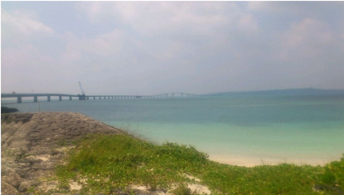
(建設中の伊良部大橋。完成するともしかしたら日本一長い橋? 撮影 長光一寛)
