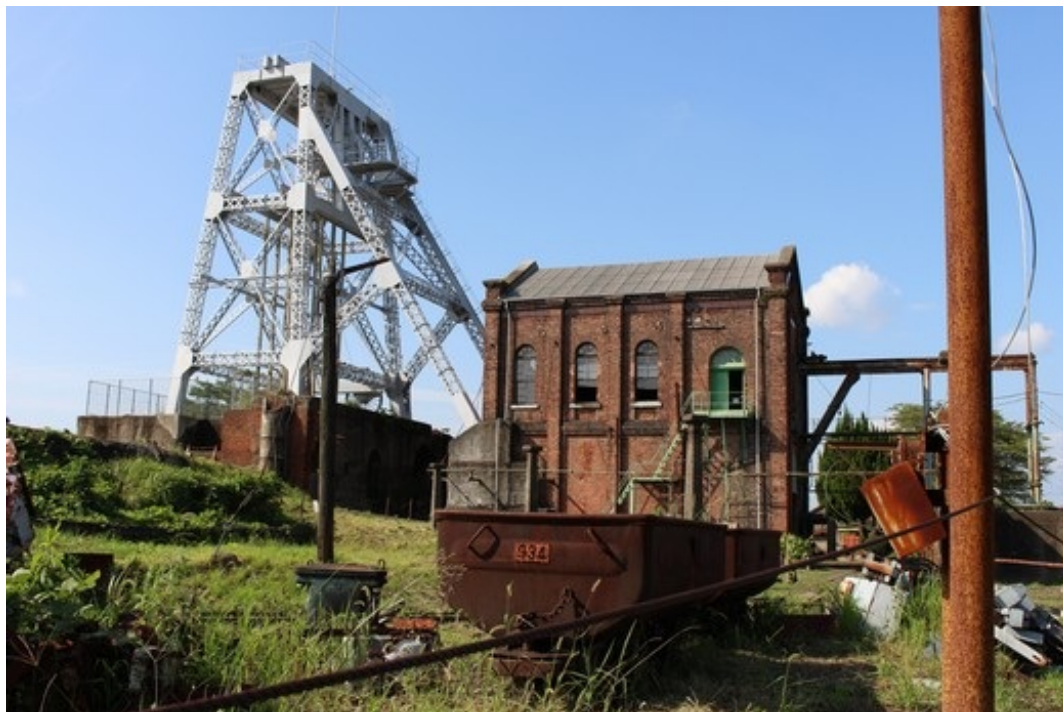
「第二豎坑櫓（だいにたてこうやぐら）及び 第二豎坑巻揚機室（だいにたてこうまきあげきしつ）」
