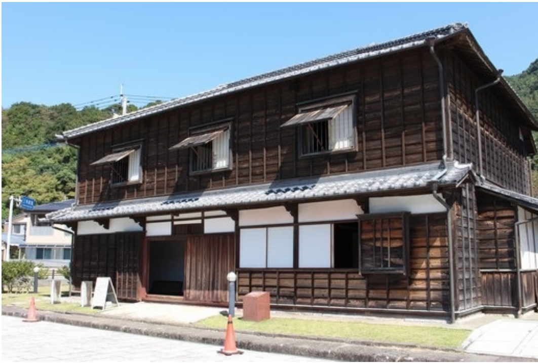
「旧高田回漕店（きゅうたかだかいそうてん）」です。 明治20年代に建てられたといわれています。荷物や乗客を扱っていた回船問屋です。
