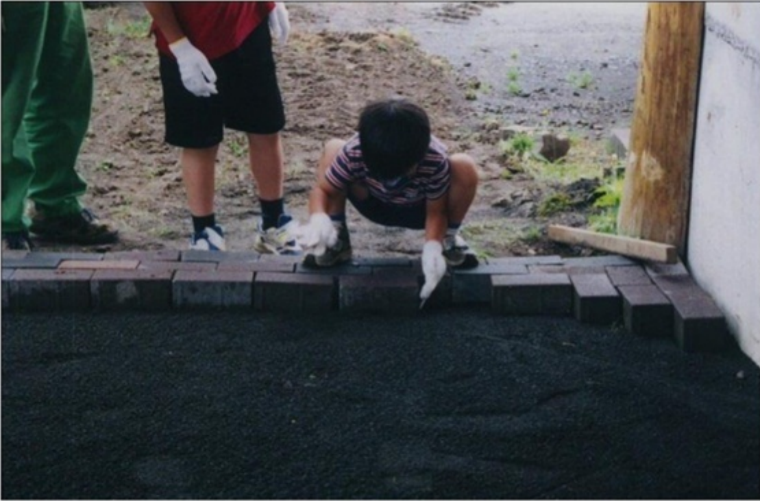
外構工事 インターロッキング敷設
