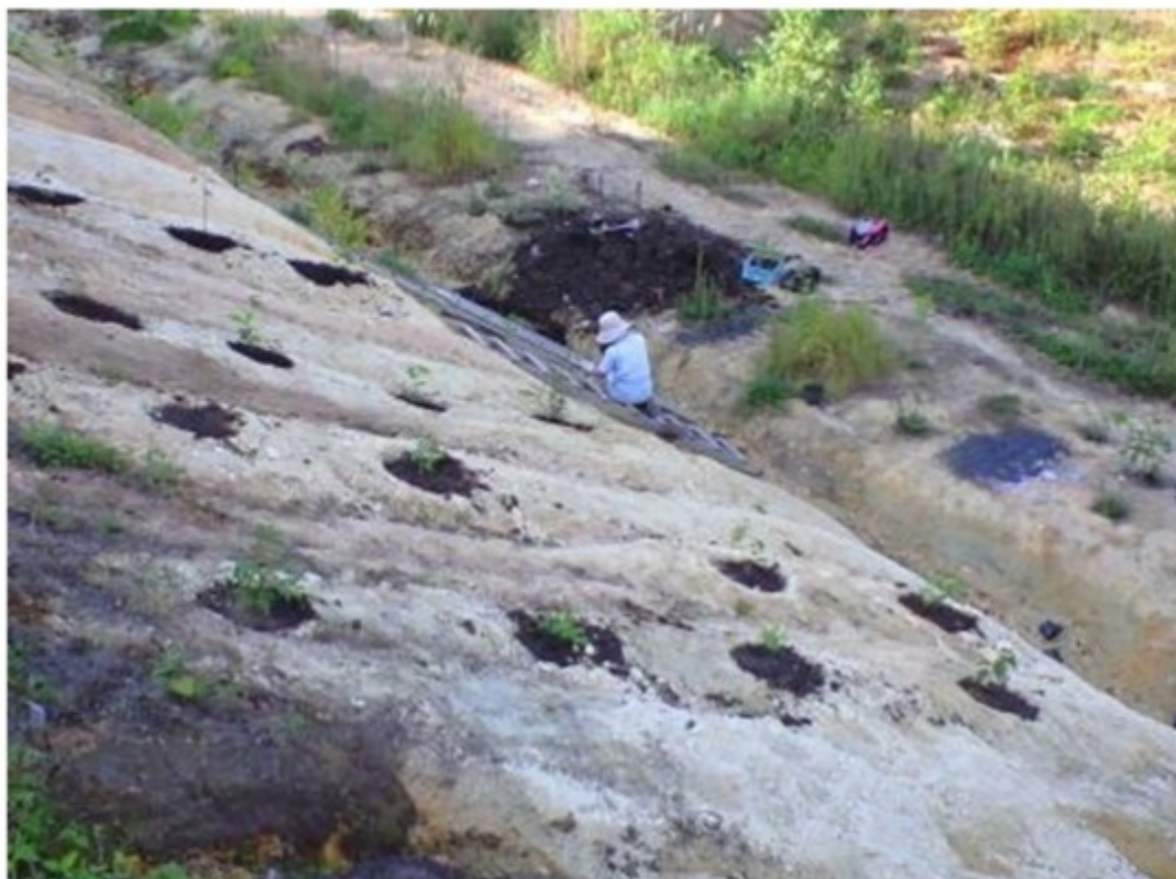
急斜面での梯子を使った緑化作業
