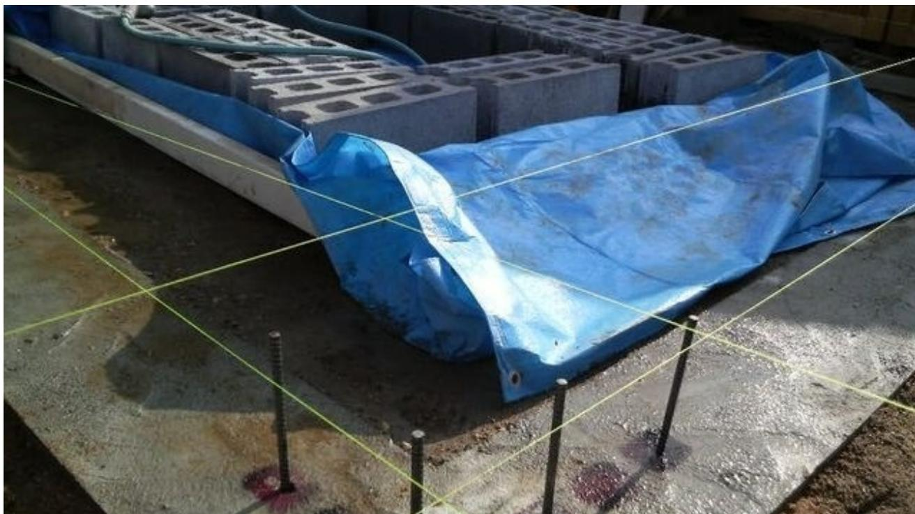
基礎コンクリートを流し込んで周りを土で埋め戻したところです、この上にブロックを並べて基礎の高さを出します。
