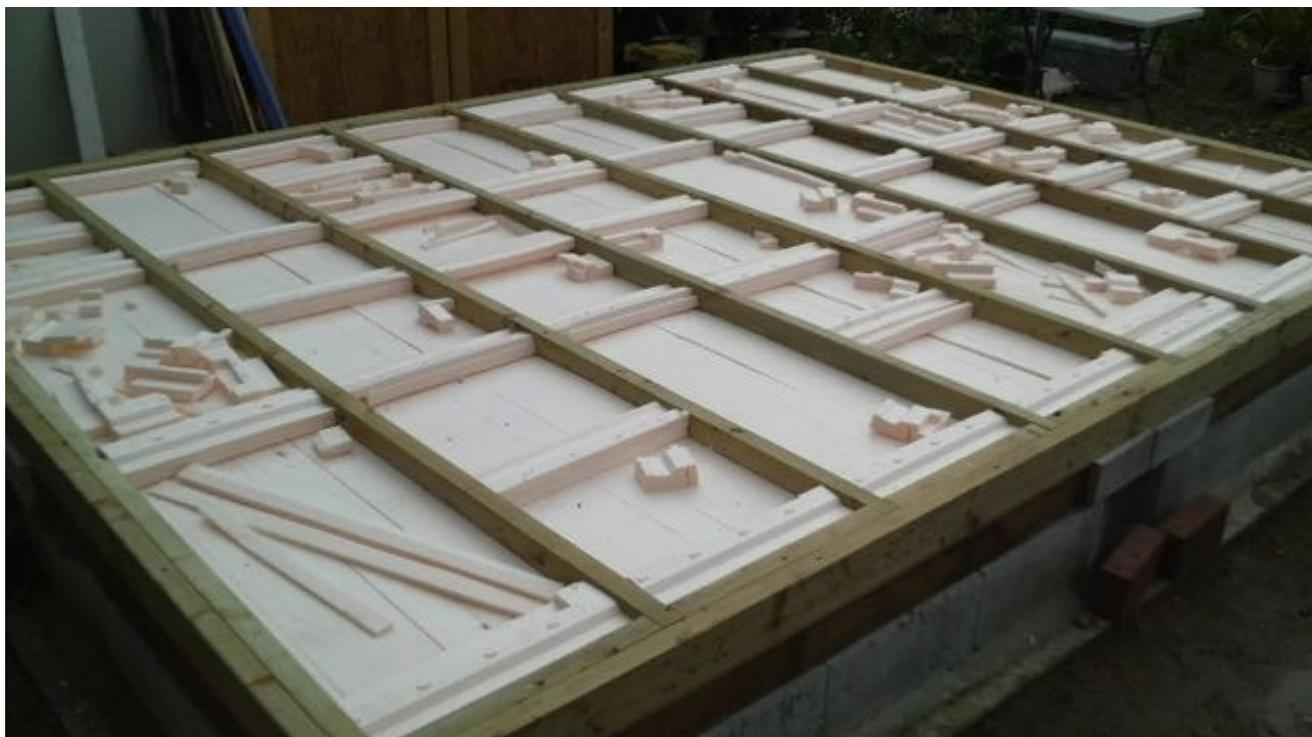
床下部分に断熱材を敷き詰めているところです、物置にしては手が込みすぎです。
