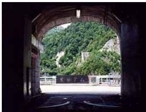
(トンネルの出口)
