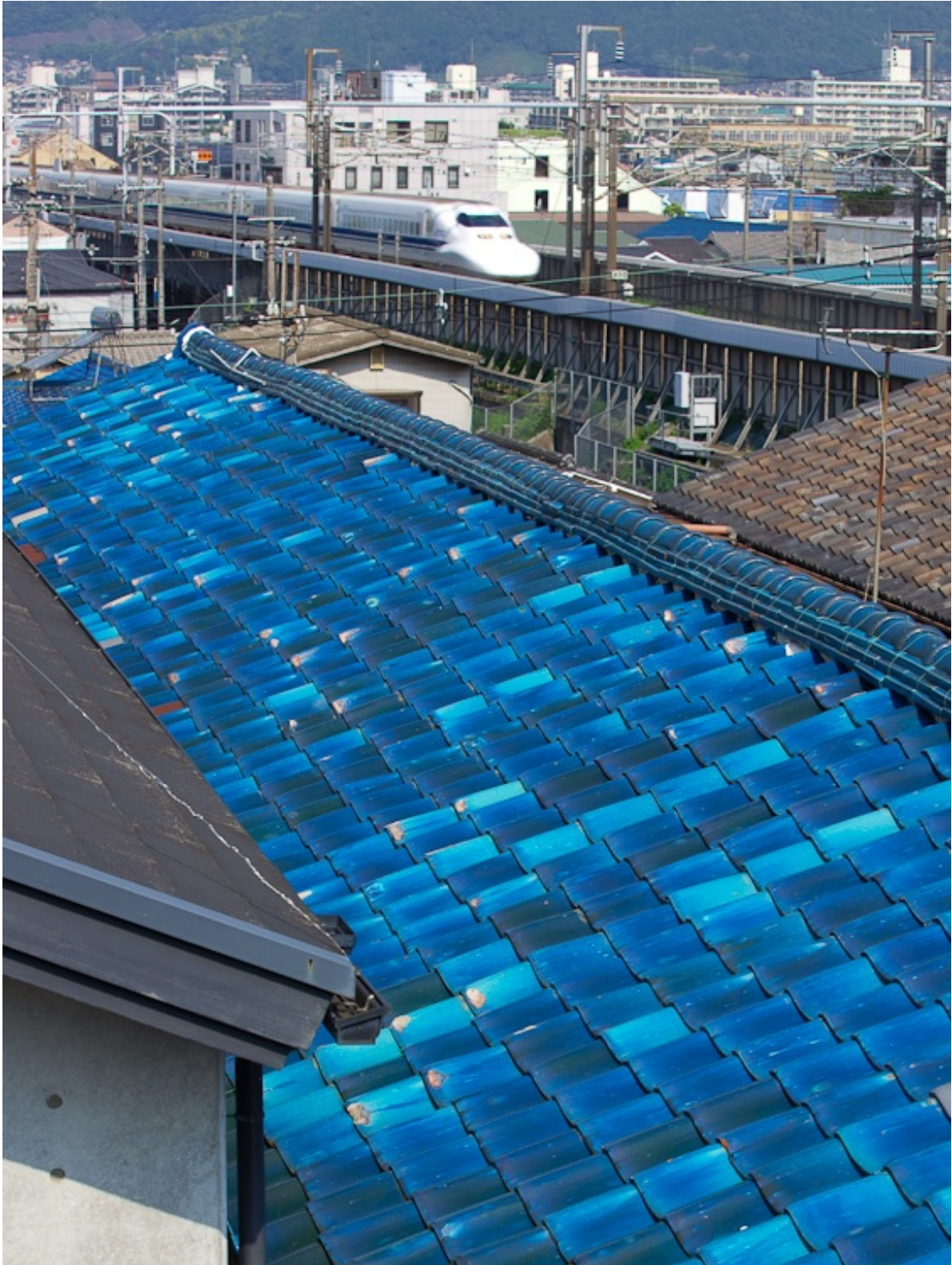
ブルーの瓦屋根。 2010.07.26 京都
