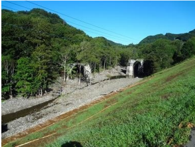
崩壊しつつある橋
