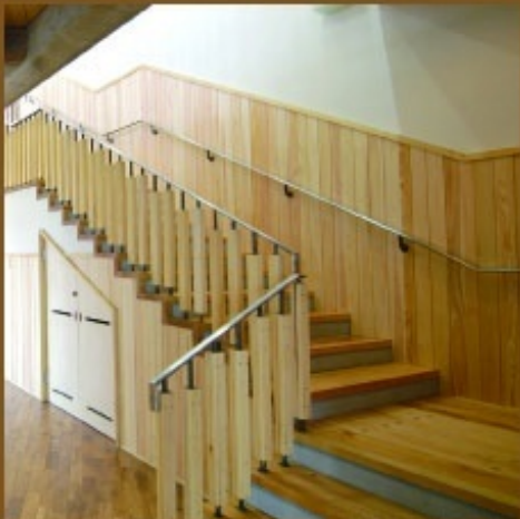
松井巧の一枚板の階段の踏み板。本物の素材感を楽しむことができます。
