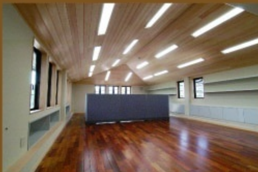
天井に無垢の杉板を貼ることで落ち着いたオフィスになっています。
