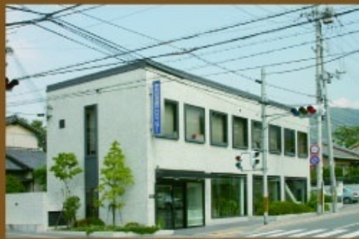
増築前の建物。RCの為に大きな構造の変更は不可能でした。
