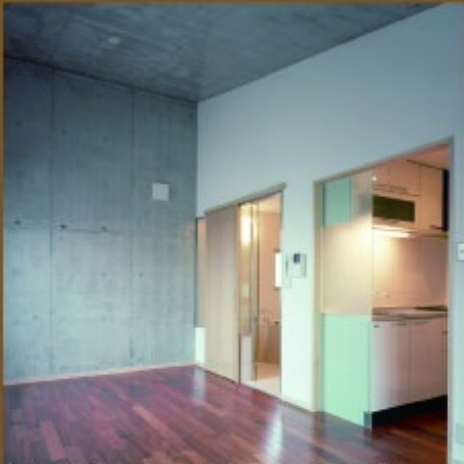
床はビンカドの自然のフローリング。壁と天井はRC打ち出し。
