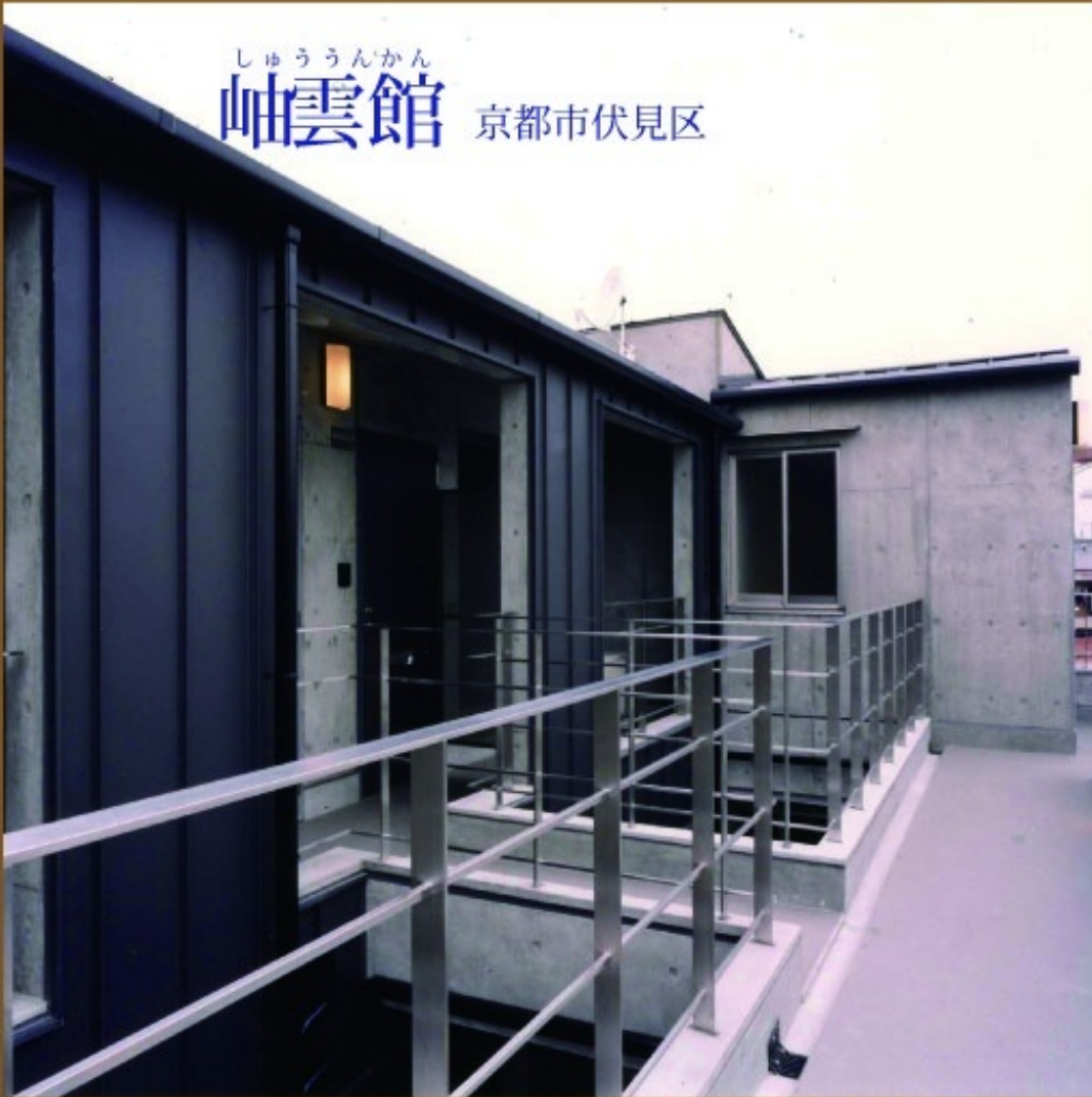
各住戸へは外部の廊下からアクセスを行います。写真は3階部の外部通路です。
