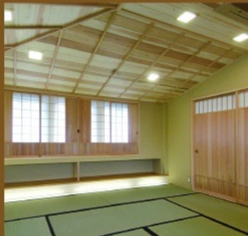
アルミサッシの内側に内障子を設け、柔らかな光にしています。
