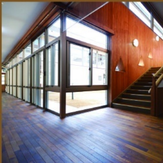
階段の壁は、スギ板貼り。手摺は北山杉の丸太を活かした自然感のある階段としています。
