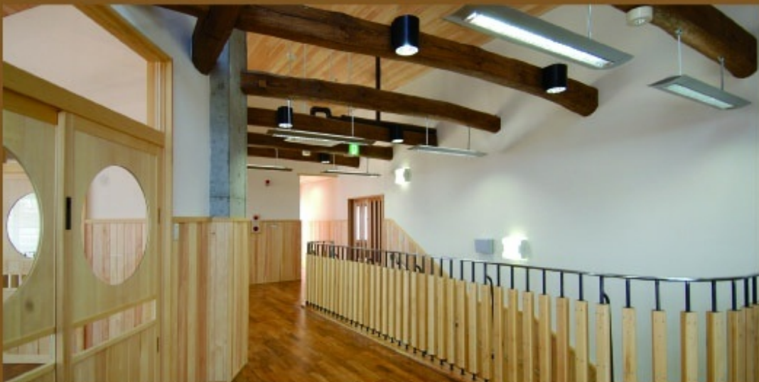
内部に井板材を用いると、落ち着いた空間が生まれます。ゴロンボ(丸太の梁)は、岐阜県からの調達です。
