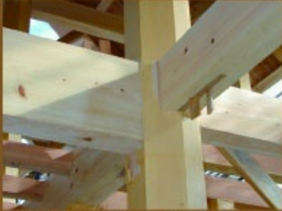
葺い工法による六角柱と梁の接合部です。
