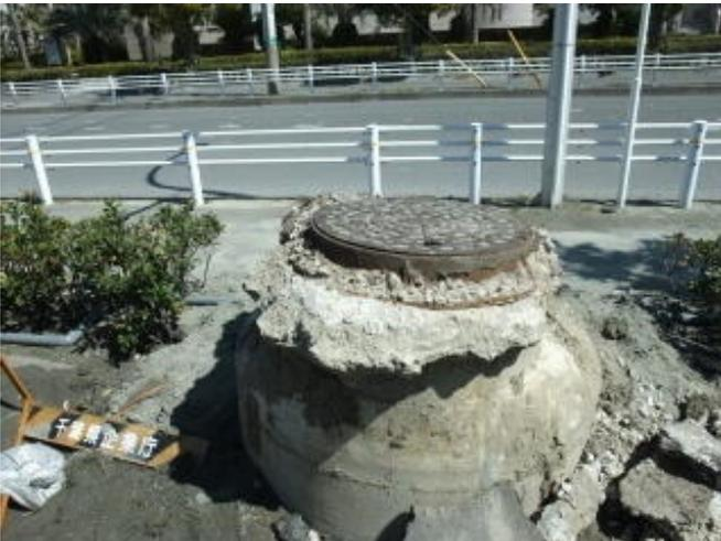
液状化現象といえば、マンホールといわれるほど印象的な現象です。これは地面が震動し液状化現象が発生すると比重の小さいマンホールは水に浮くように浮上してしまうために発生します。浮上したなら沈むのでは？と思われますが、振動が終わると砂の粒子がすぐに再堆積し下部に固まってしまうため、マンホールだけが浮いたまま固定されてしまうようです。最近では、マンホールが浮上しにくい工法も開発されているようです。
