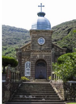
積み上げられた石には、ミで削った跡が見られ、当時の人々が人力で石を切り出したことがひしひしと伝わってくる。
