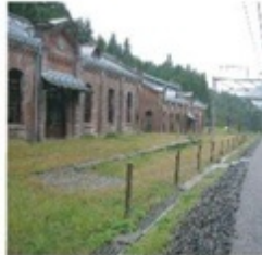
旧丸山発電所と、アプトの道。国の重要文化財でもある。
