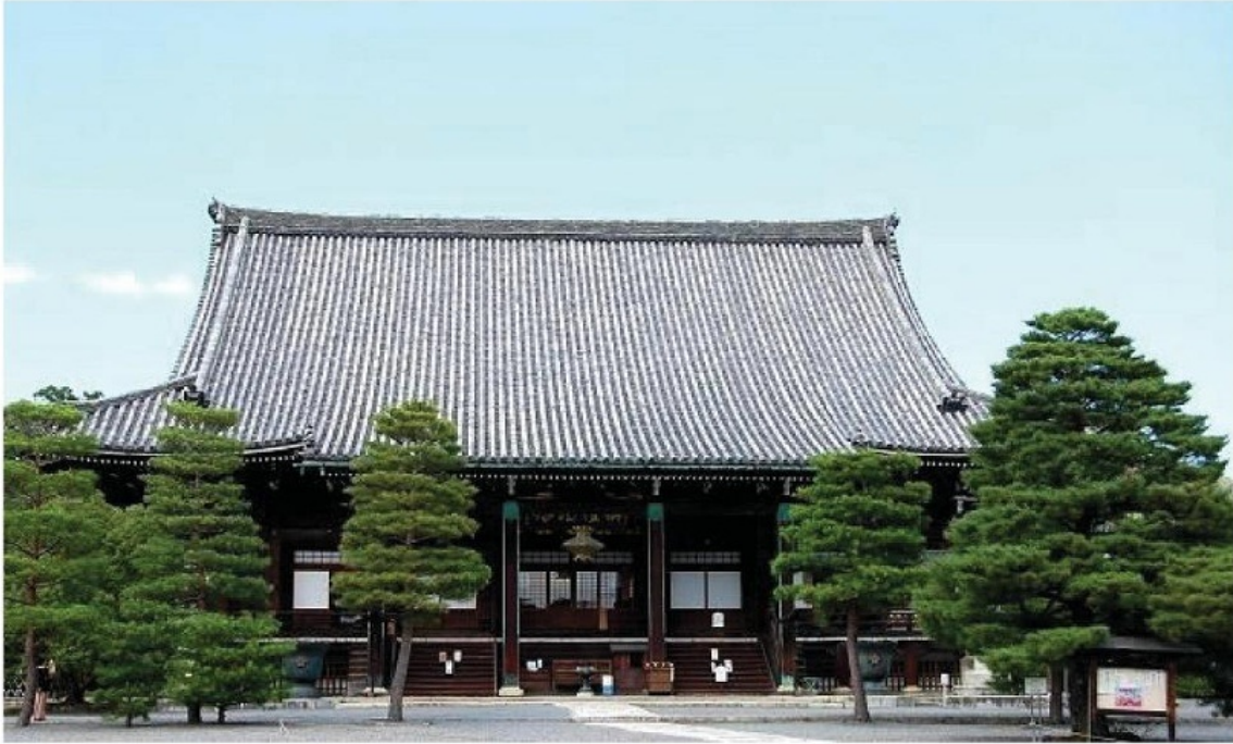
本堂（釈迦堂） たび重なる焼失の後、元禄 14 年（1701）再建された。単層入母屋造本瓦葺で、徳川初期の桃山建築の名残をしめす豪華さを持っている。
