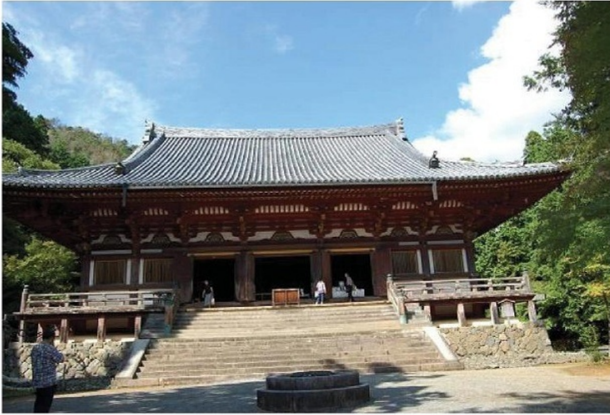
金堂 入母屋造、本瓦葺きの本格的は密教仏堂であるが、建築年代は新しく、昭和9年（1934）に実業家山口玄洞氏の寄進で建てられたものである。
