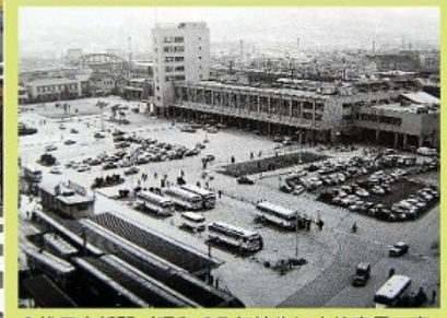
3代目京都駅 (昭和25年焼失により突貫工事。昭和27年完成) 「昭和の京都」光村推古書院
