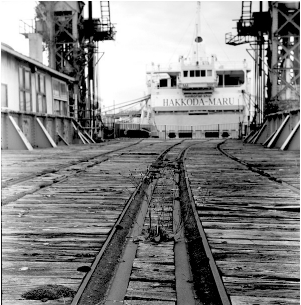
青森駅から徒歩5分ほどの「青函連絡船メモリアルシップ 八甲田丸」に向かいます。写真は運行当時、鉄道車両を引き込むのに使用された、栈橋の車輛搬入橋からの眺め。
