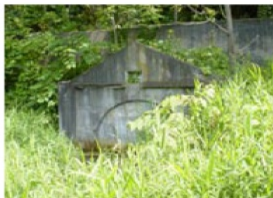
公園の奥にある坑口跡
