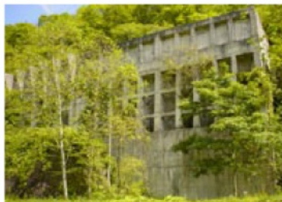
巨大な原炭ポケット 採掘された石炭は、ここに集められた
