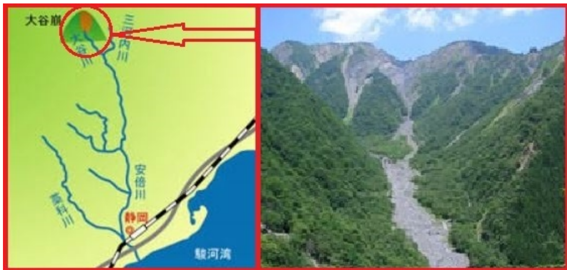
（大谷崩れ・森林防災工学研究室 ホームページより）
