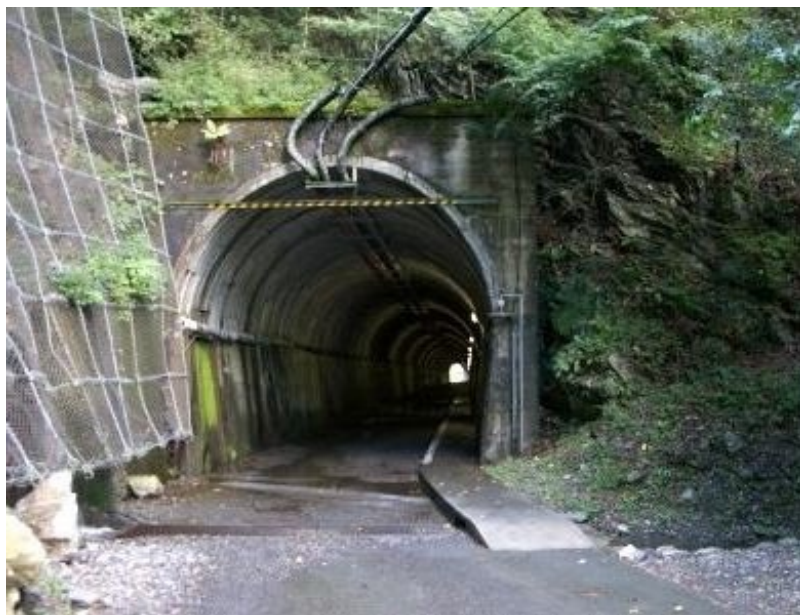
(天使トンネル)
