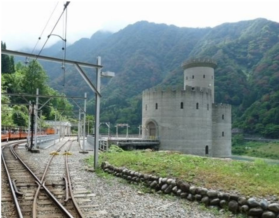
(新柳河原発電所)
