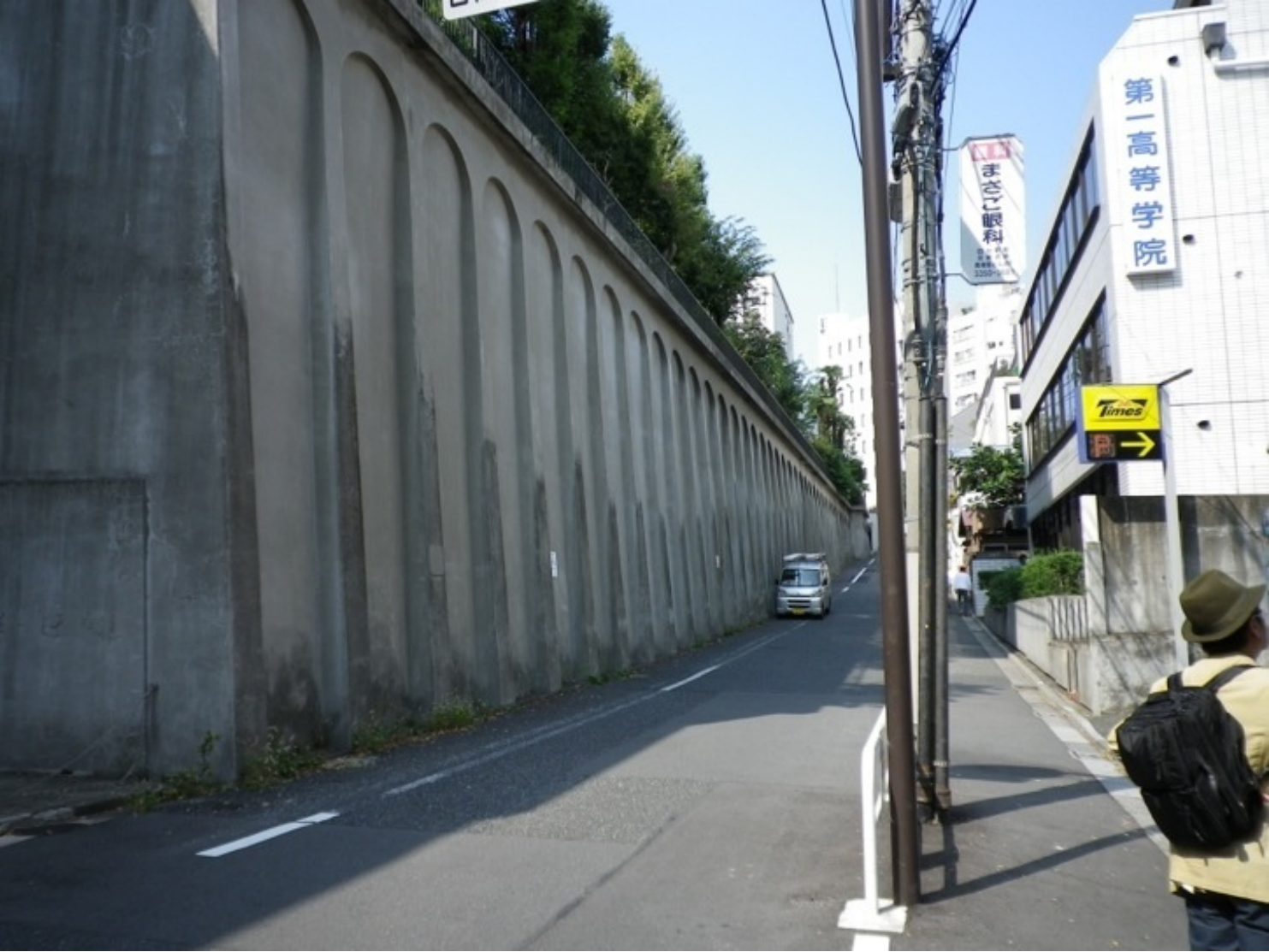
擁壁。ちょっと凝ったリブ装飾が、少しは圧迫感を和らげている。
