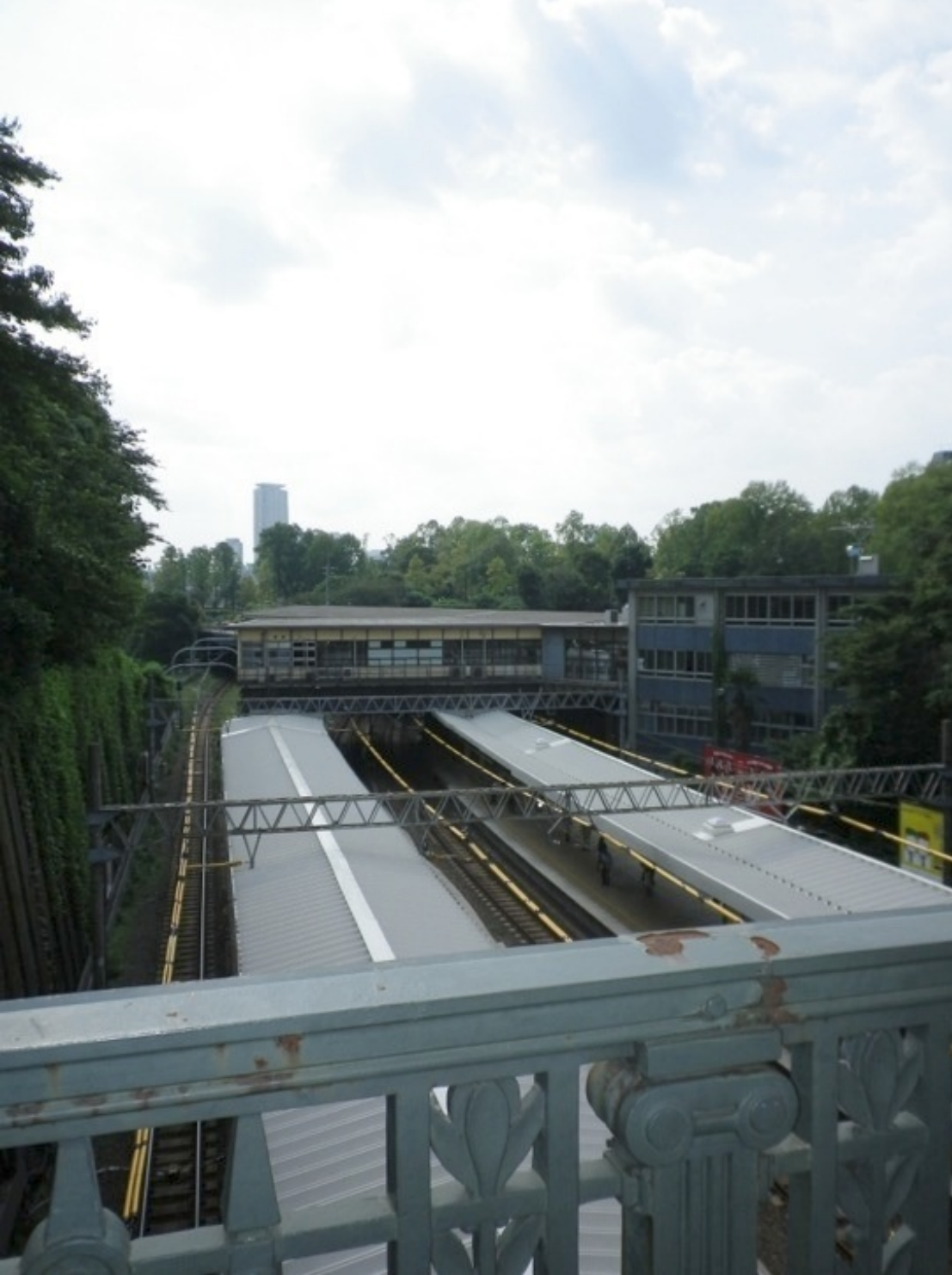
四ツ谷駅のホーム屋根を見下ろす。
