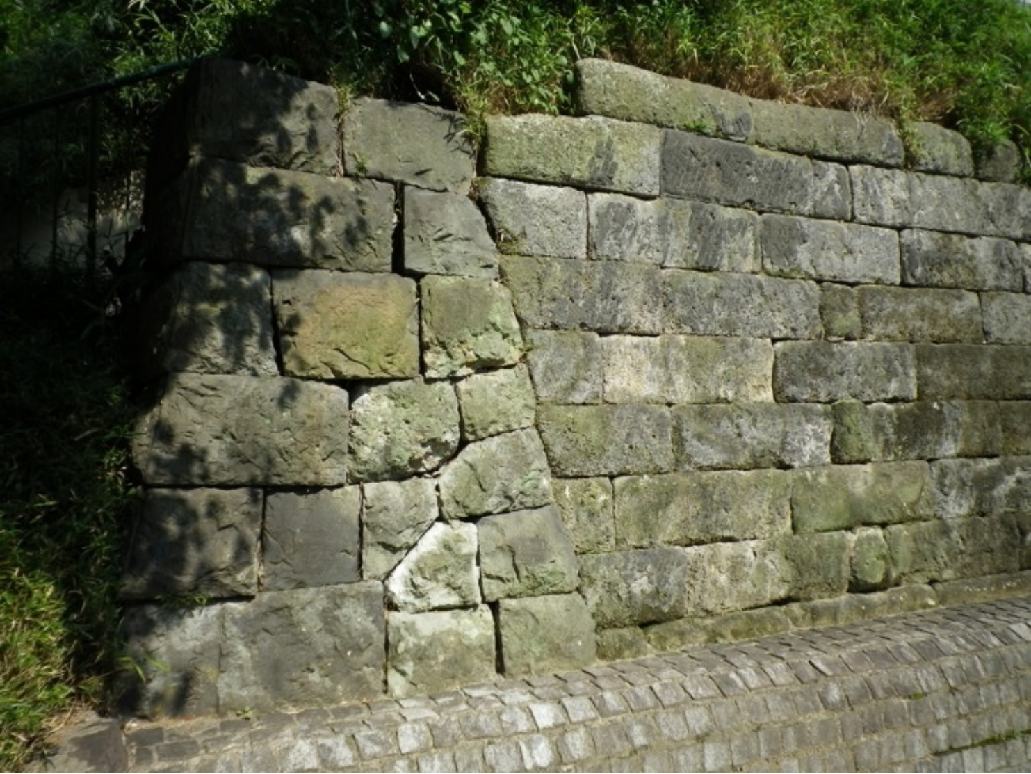
構内の擁壁。途中で積み方が変っている所が興味深い。
