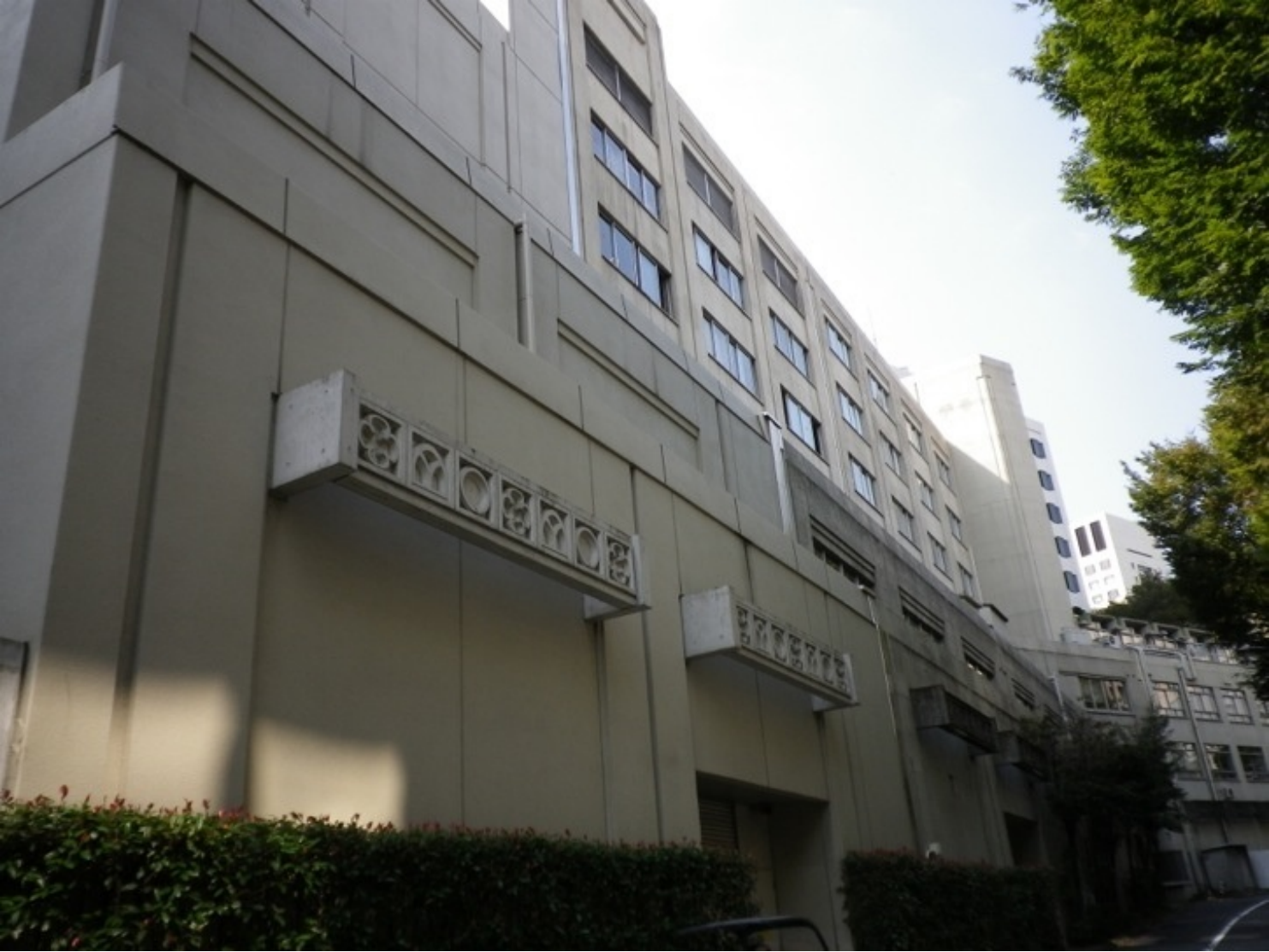
上智大学校舎。庇状の突起物（天板がないので庇の役目はしていないが）に、意味あり気な装飾が
