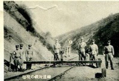
沿線の軌道建設
