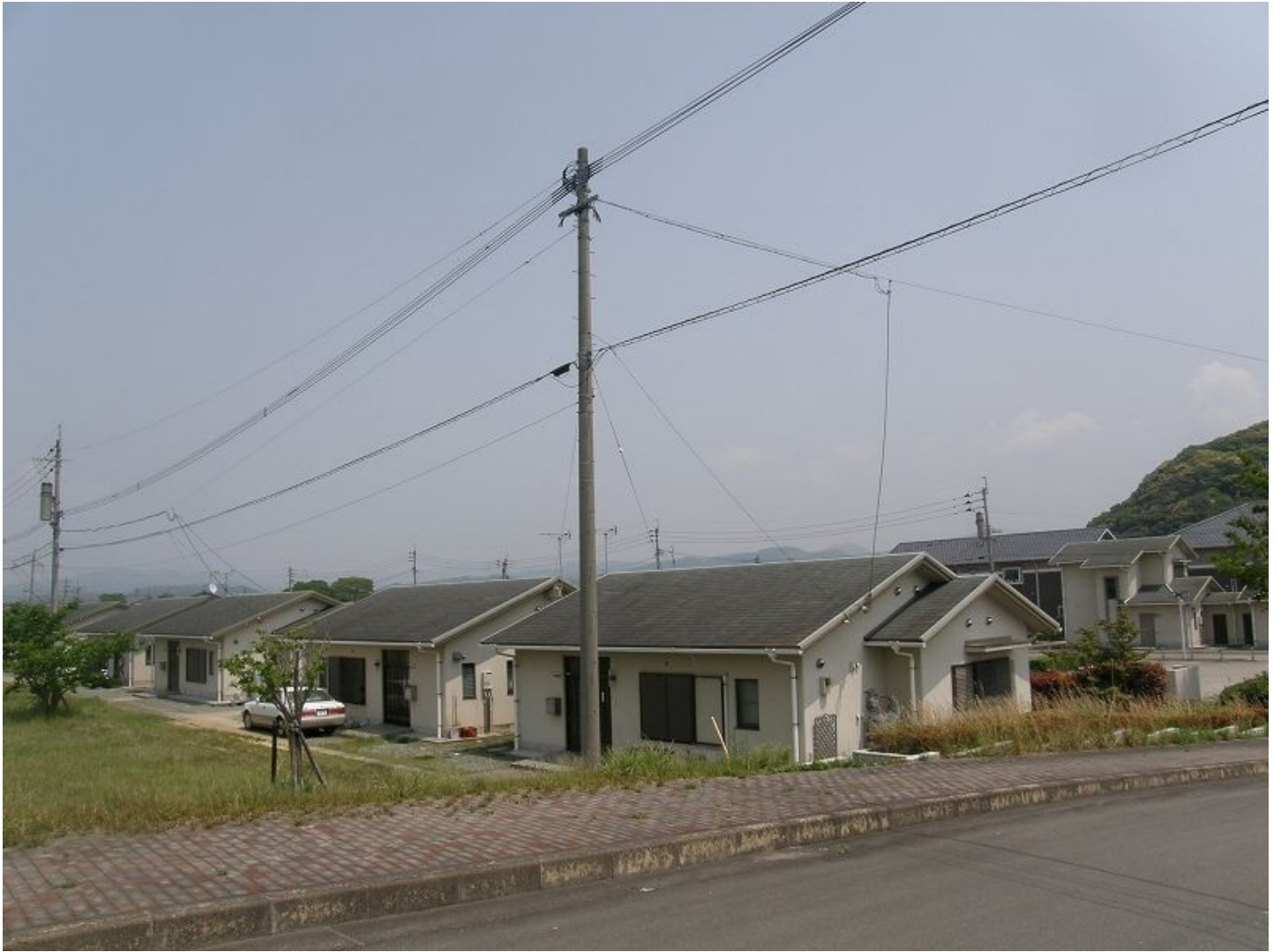
矢部川堤防からさくら台住宅を見下ろす。
