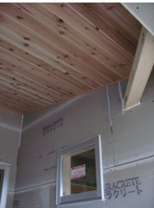
↑なんと屋外の天井にも杉板を貼っていただいています
