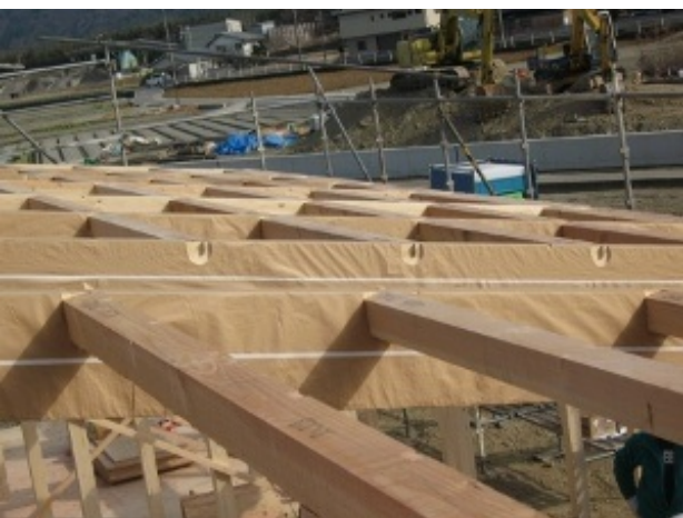
★上棟式の模様3（屋根からの撮影）
