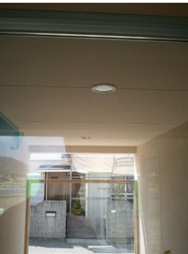
◆外玄関の照明
