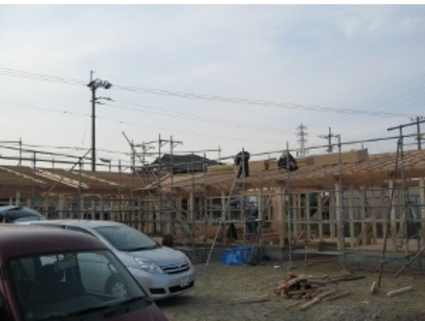
★上棟式の模様1（正面からの全景）
