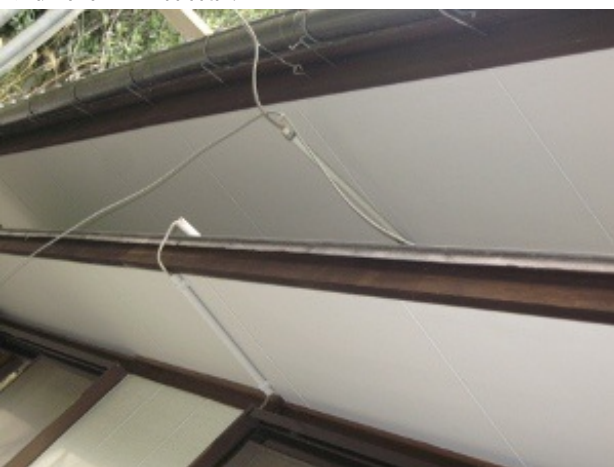
◆側面の 1 階部分
