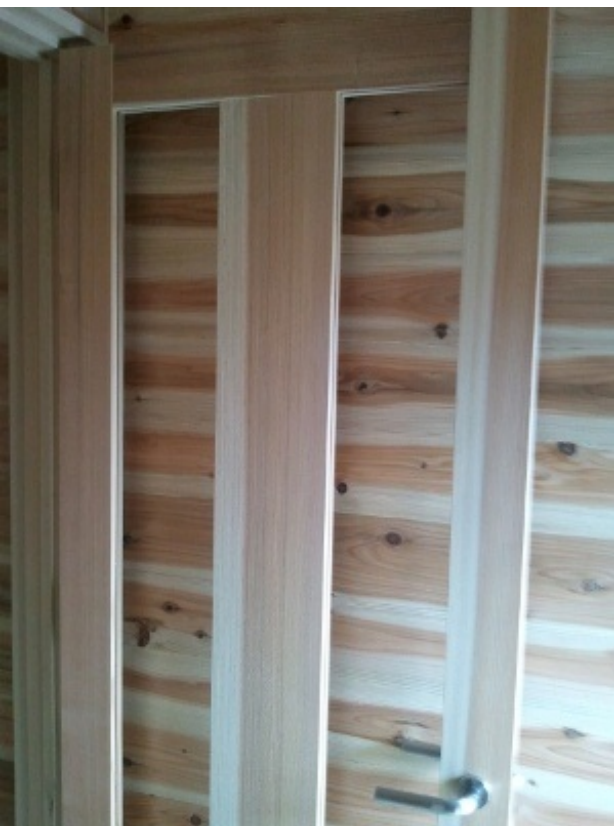
※ガラスが入っていない状態
