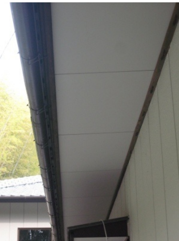
◆裏庭側の1階部分
