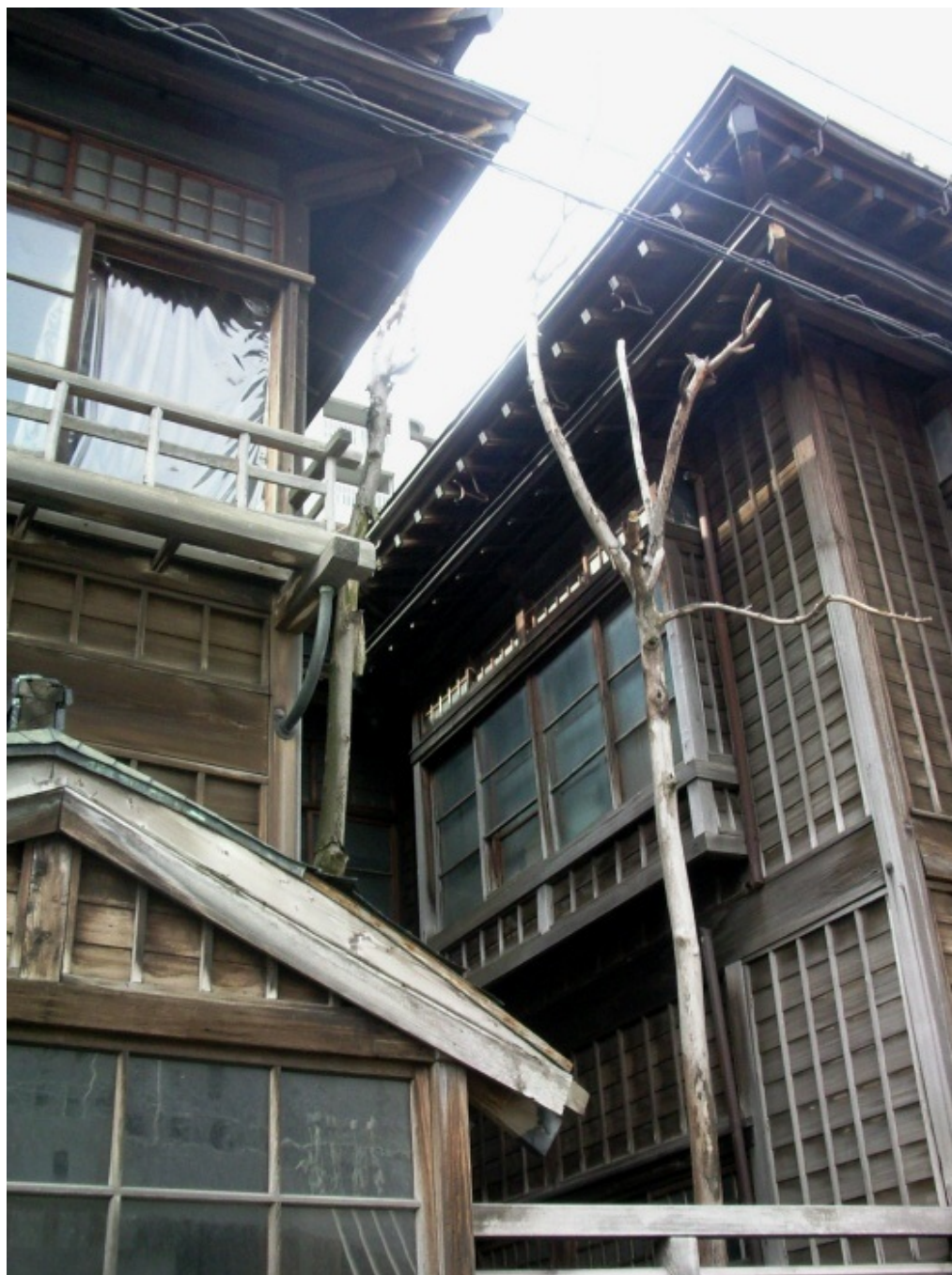
カフェと雑貨屋さんで改装されつつある古民家。
