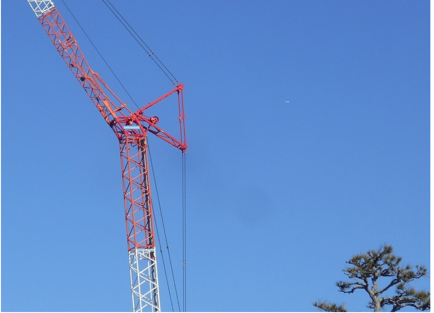
クレーンの近くを飛んでいたのが撮影。
