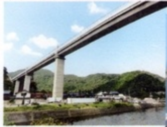
余部鉄橋(現橋梁) →
