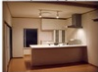
電気・配管工事
