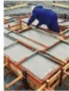
現地施工(基礎から全て)を担当いたしました。
