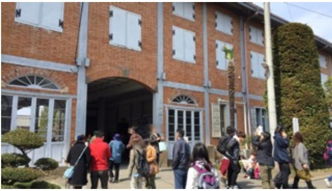
建物は、木で骨組みを造り、柱の間に煉瓦を積み上げて壁をつくる
