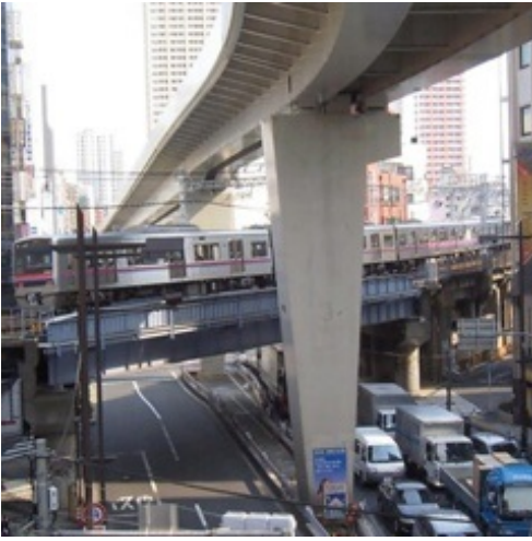
陸橋から日暮里方面（下の道路は尾久橋通り）
