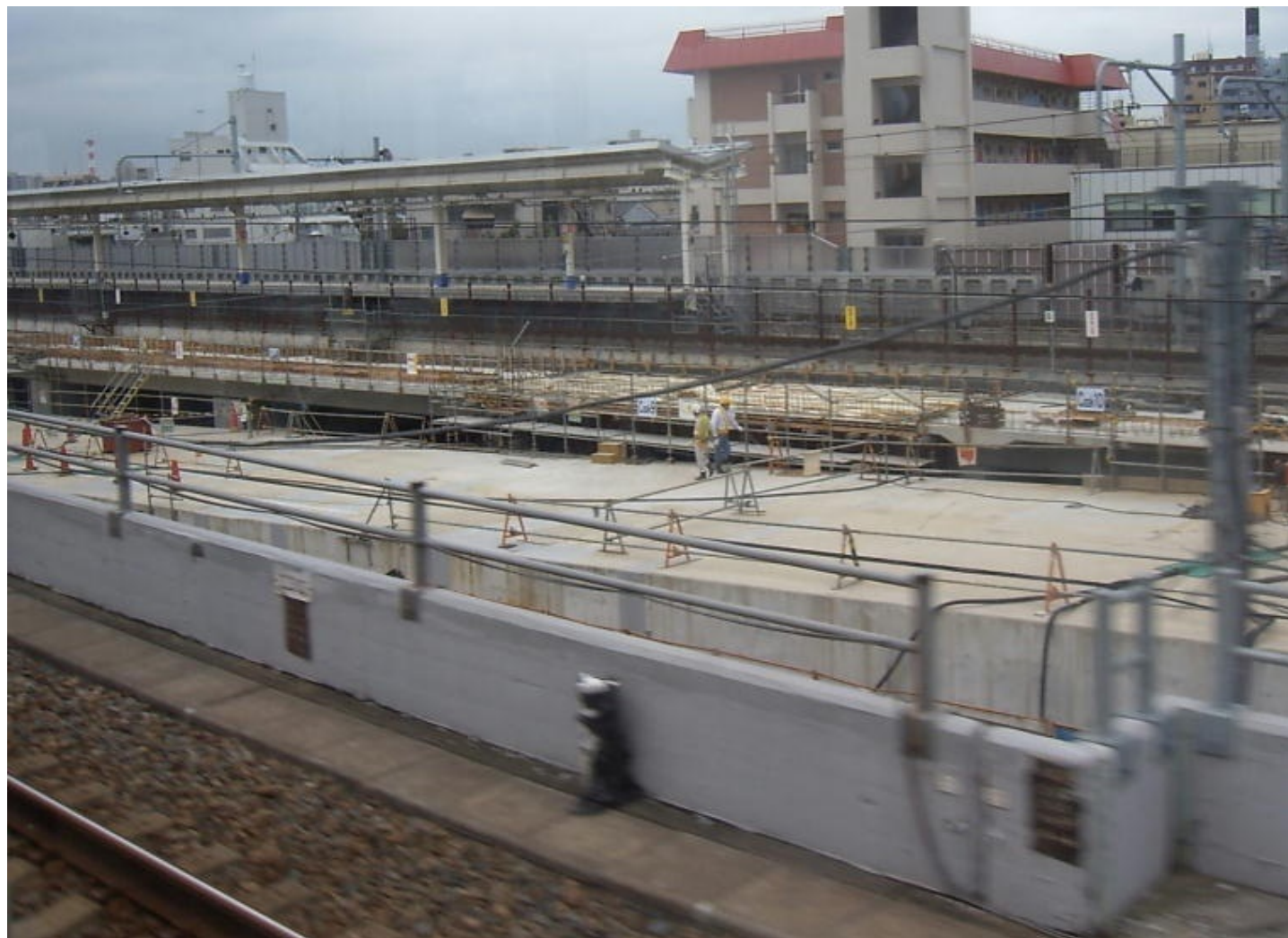
日比谷線車窓から見た南千住駅周辺の工事現場
