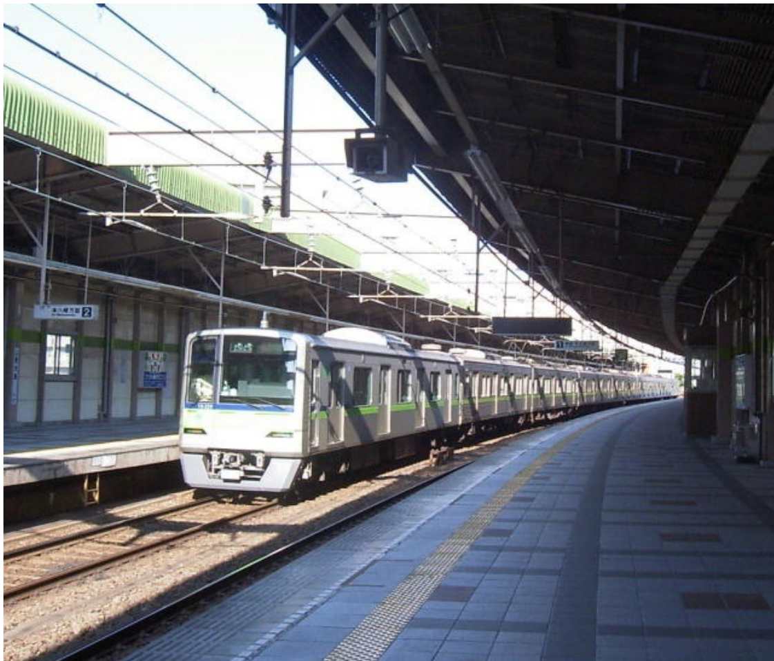
下りホームを発車した時の様子（緩やかにカーブしているのがわかる）
