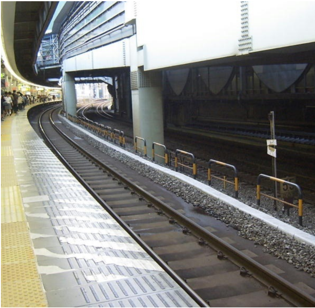
品川・東京方面のホーム（結構なカーブだが、「足もと注意」の表示が見当たらない）
