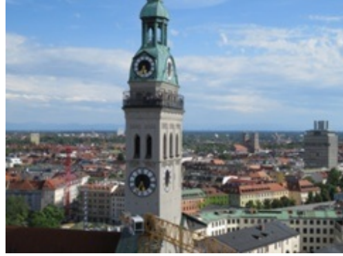
ペーター教会尖塔
