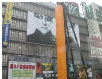
解体工事の準備中
