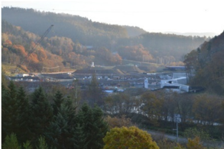
建設中のサンルダム（下川町）
