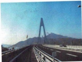
↑ 生口大橋の上り この橋は、車道の橋が水 自転車 + 歩行者道。
